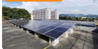
辦公大樓屋頂
